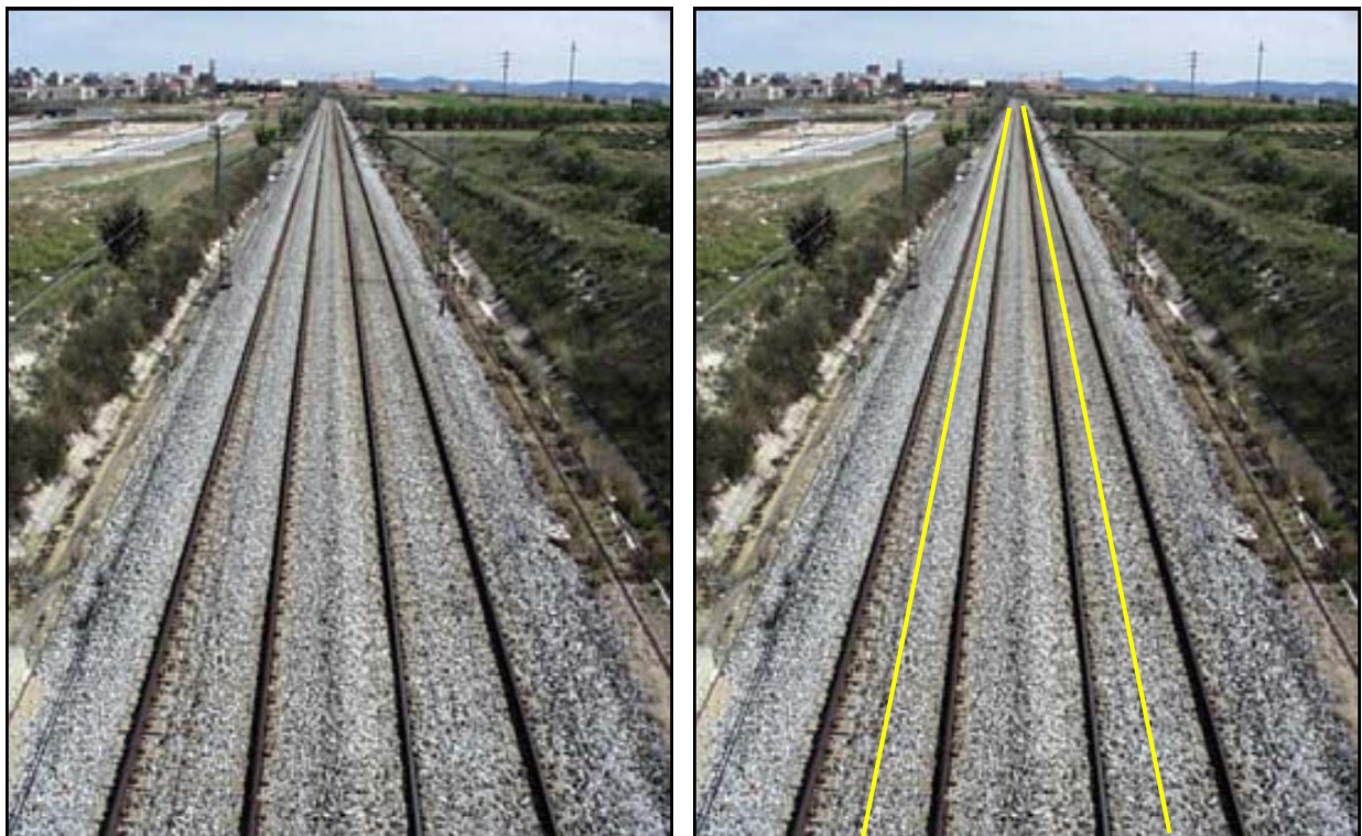
Ejemplo vía férrea.
